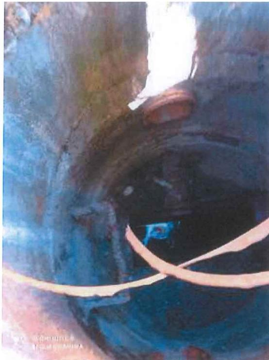
Fotografía ilustrativa de colector se salida de las viviendas a cota de colector de la calle
